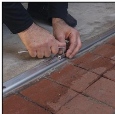
**⚠ Hinweis: Je nach Füllmaterial (Herstellerangaben beachten) sollte die Bodenschiene erst nach 24 Stunden belastet werden**
